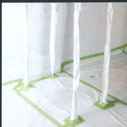
吊り足場のチェーン養生に
